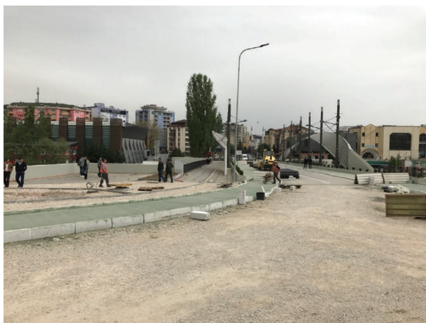
Слика 9. Радови на обнови Главног моста као део завршнице уређења пешачке зоне
